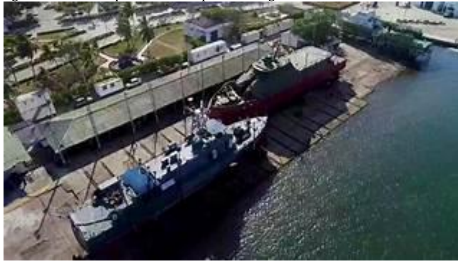
Figura 4. Sistema slip de varada en planta Bocagrande de COTECMAR
